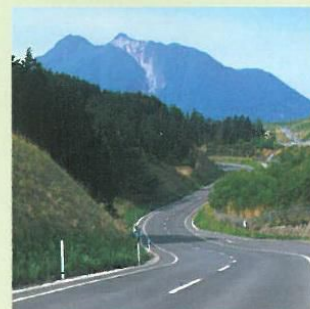
轻型采矿调备,隧道与地铁
